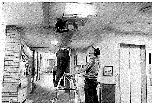
関電、中電による照明器具の点検掃除
