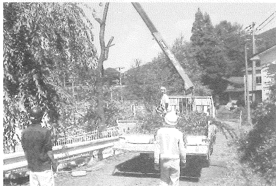
クレーンで引き上げます
