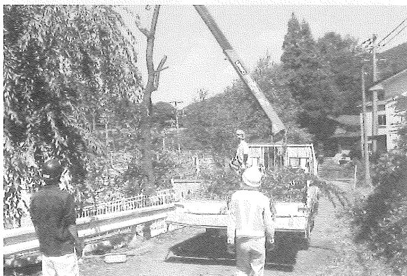
クレーンで引き上げます
