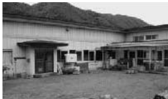
昭和47年建築の旧西保育園 (西野)
