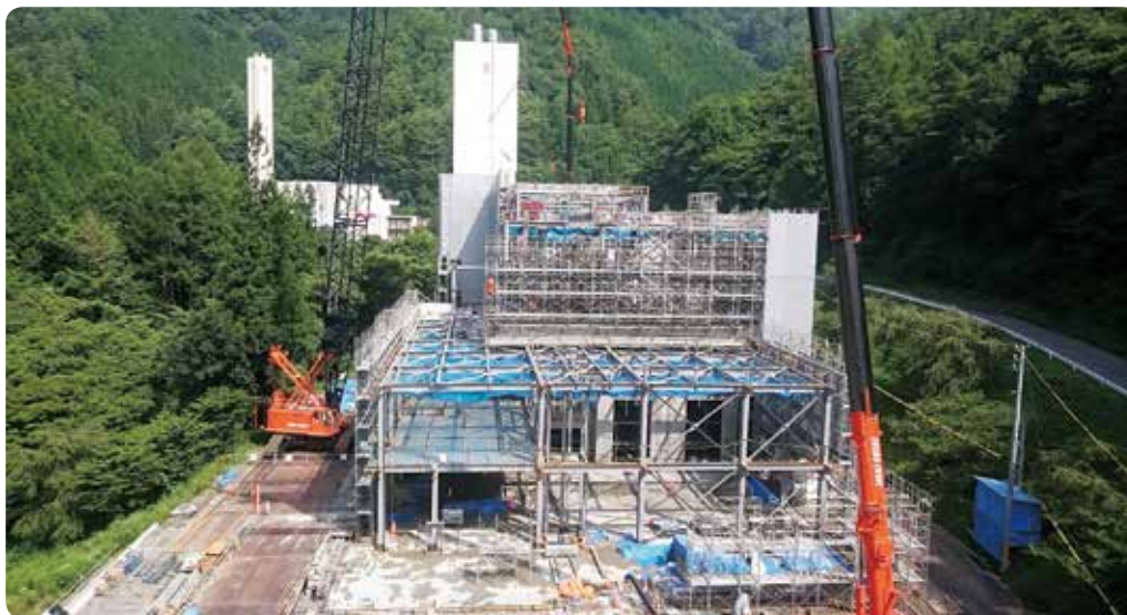
正面入口側から工事中の新しい施設を望む（左奥に見えるのは現施設）
