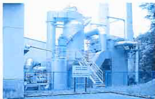
バグフィルターを含む排ガス高度処理施設 (平成12年完成)
