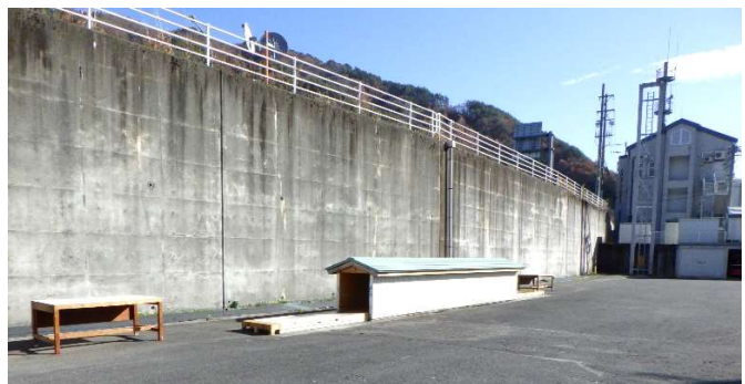
庁舎北側訓練施設
