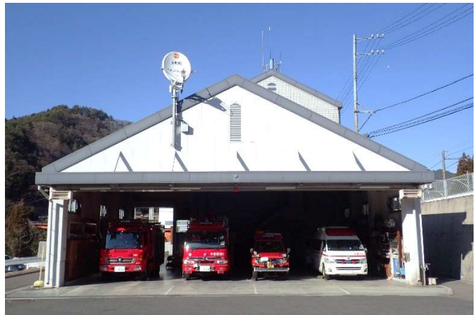
庁舎南側車庫
