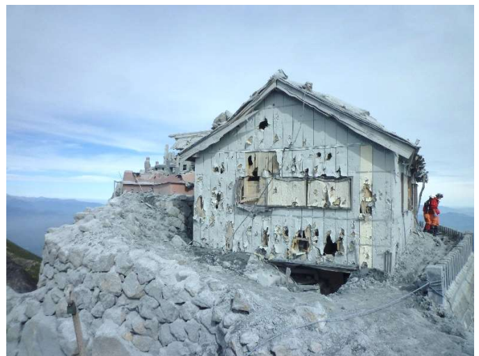
噴石により破損した山小屋
