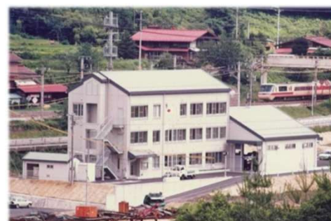
建設当時の消防本部庁舎
