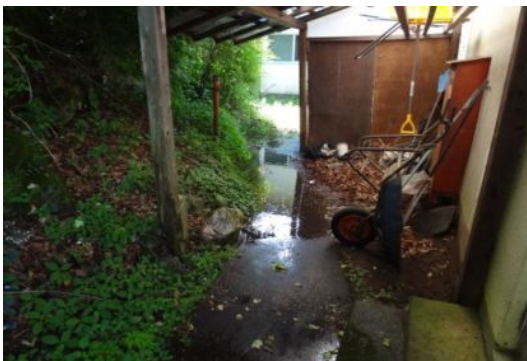
木曾寮東側避難路状況
