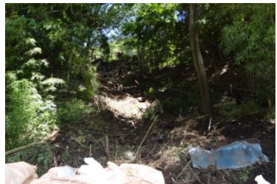
木曾寮沿線で発生した土砂災害 (2018.07.06 豪雨)
