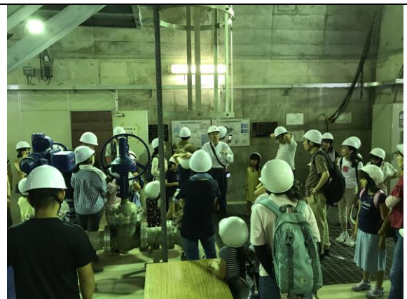
味噌川ダム（監査廊）見学
