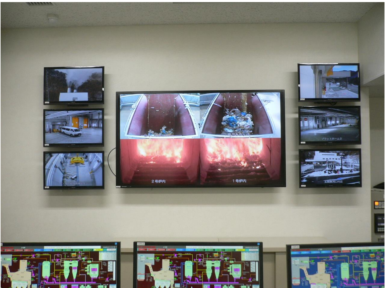
平成 30 年 1 月 12 日より試運転（ごみの焼却）を開始しました
