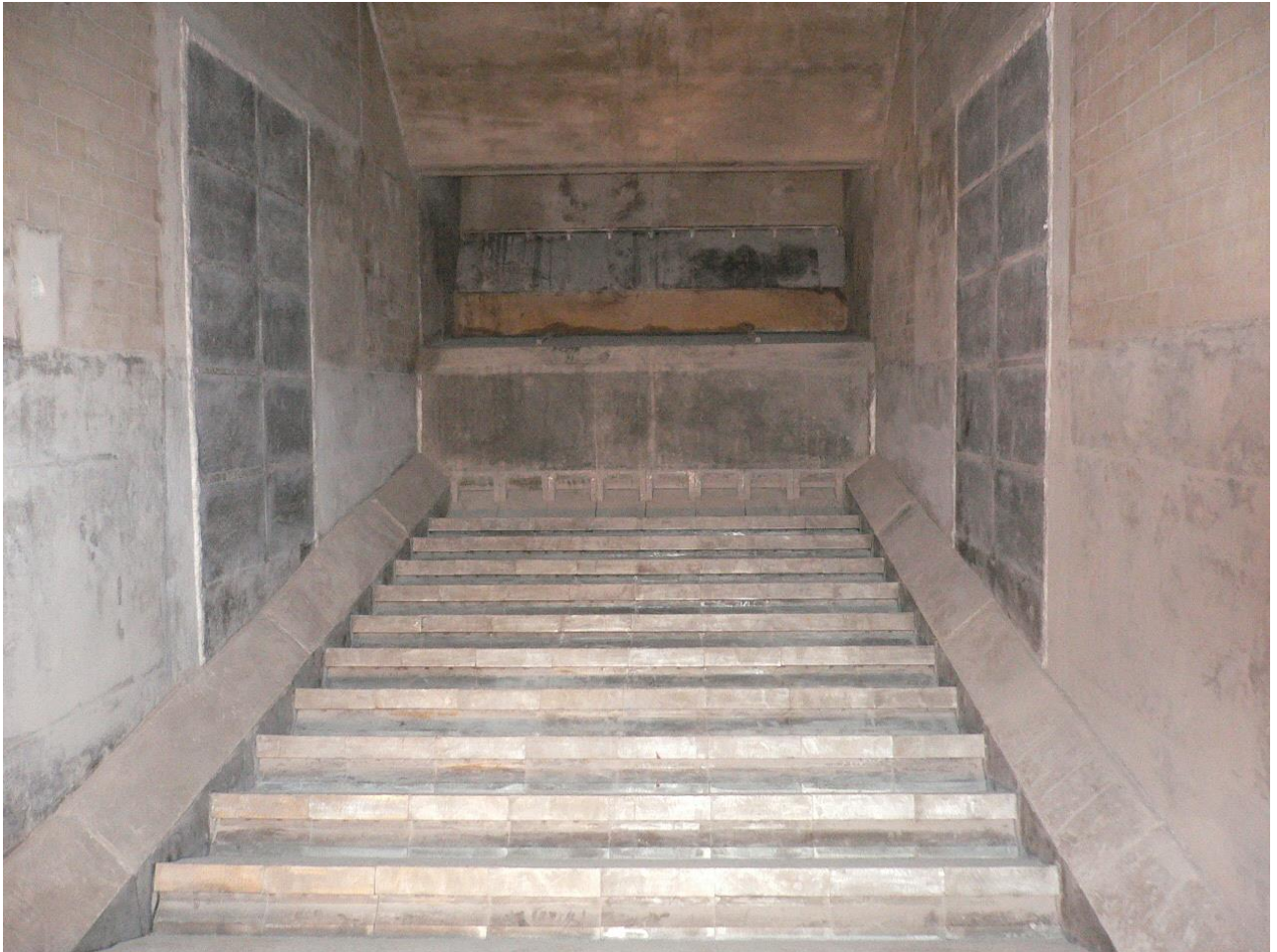
1号燃焼室 施工完了 「後燃焼装置」側から「給じん装置」側を望む 階段状に見えるのが火格子（ストーカ）
