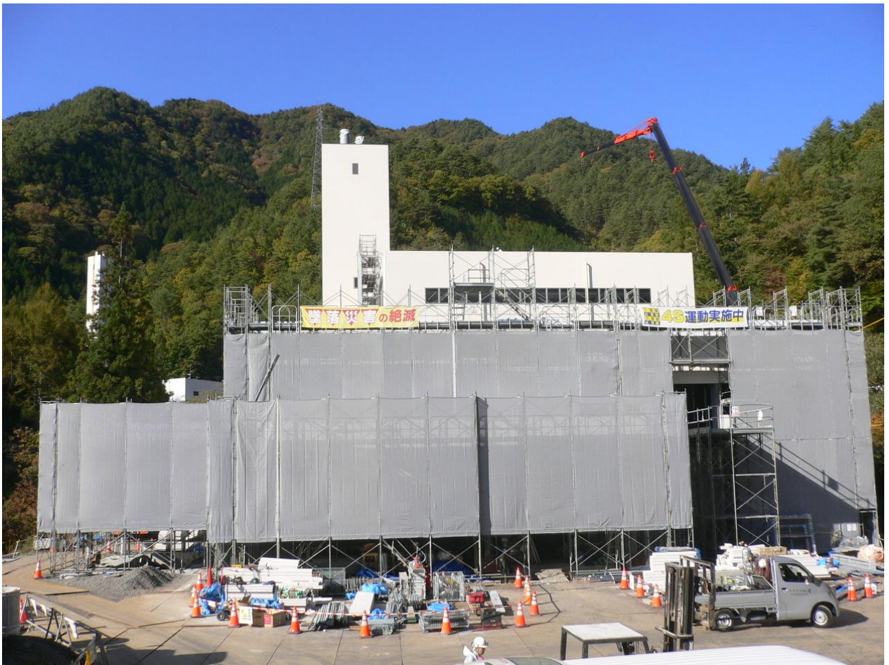
新ごみ処理施設の全景（平成 29 年 10 月 27 日現在）
