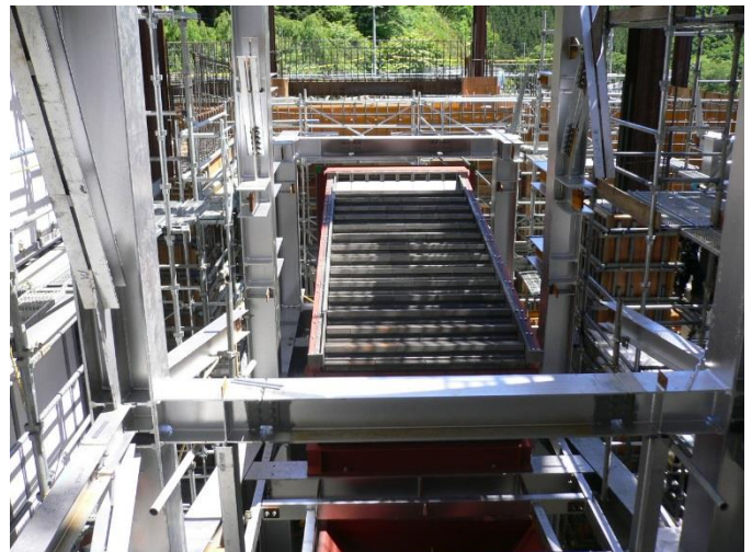
燃烧装置の据え付けを行いました（平成 29 年 6 月 9 日）
