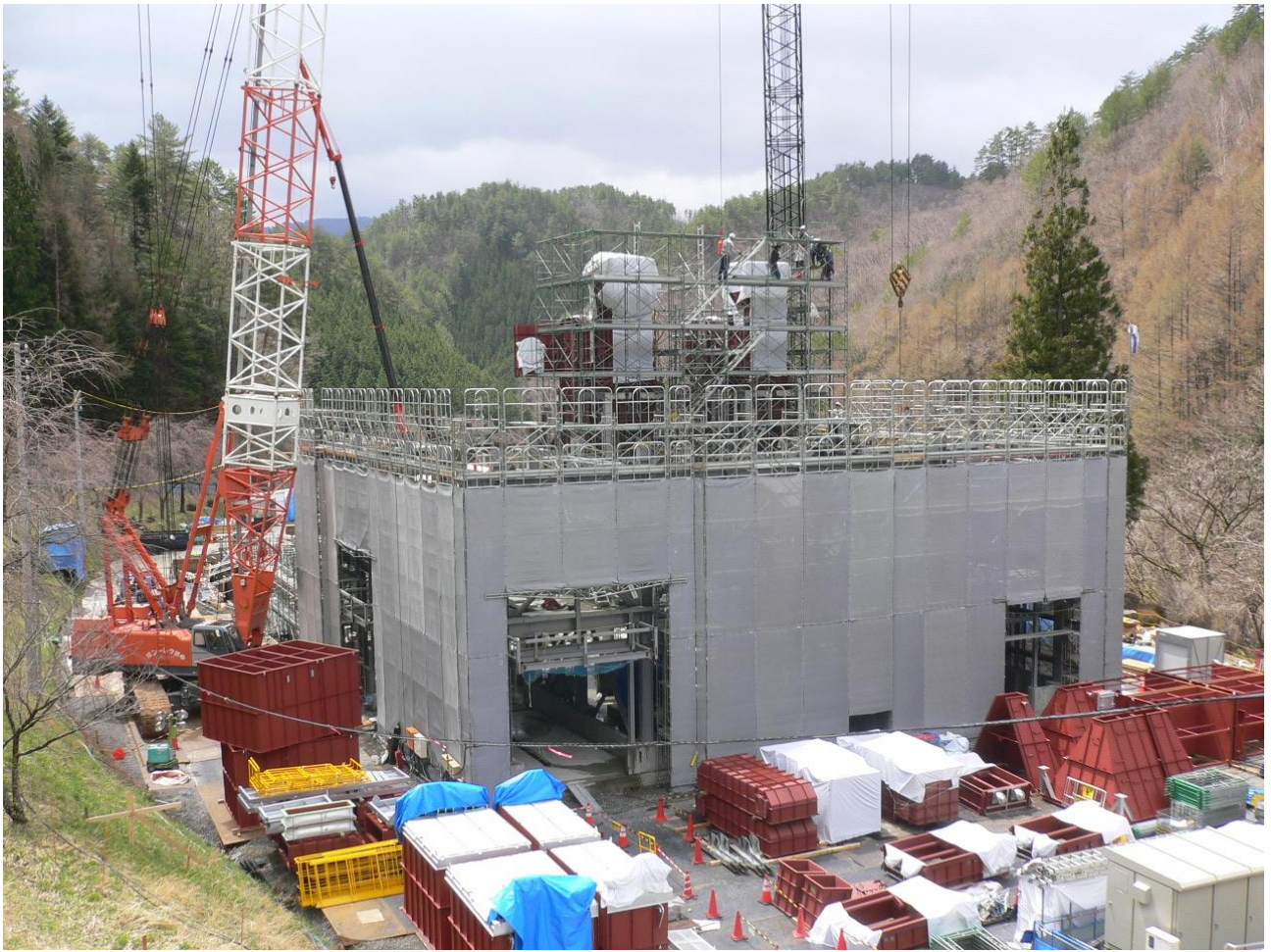
新ごみ処理施設の全景（平成 29 年 4 月 19 日現在）
