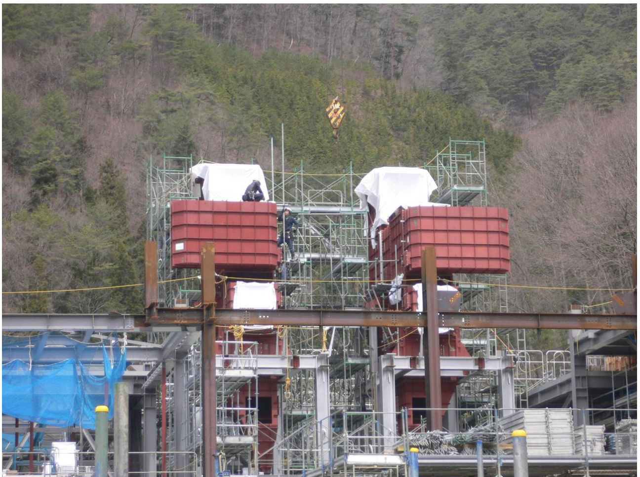
空気予熱器・減温用空気加熱器の据え付け状況
