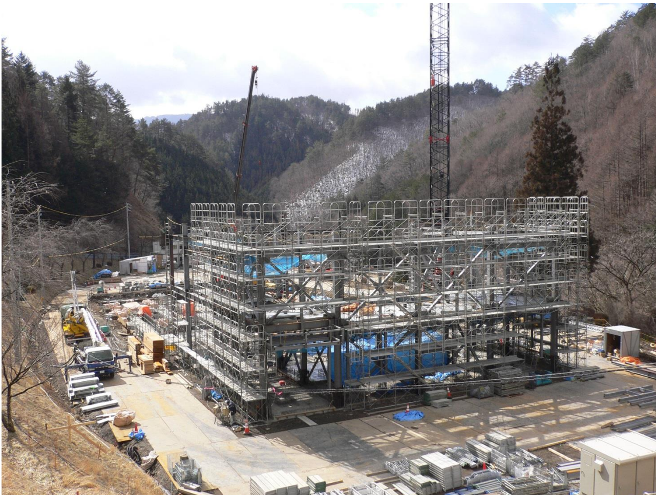
新ごみ処理施設の全景（平成 29 年 3 月 9 日現在）
