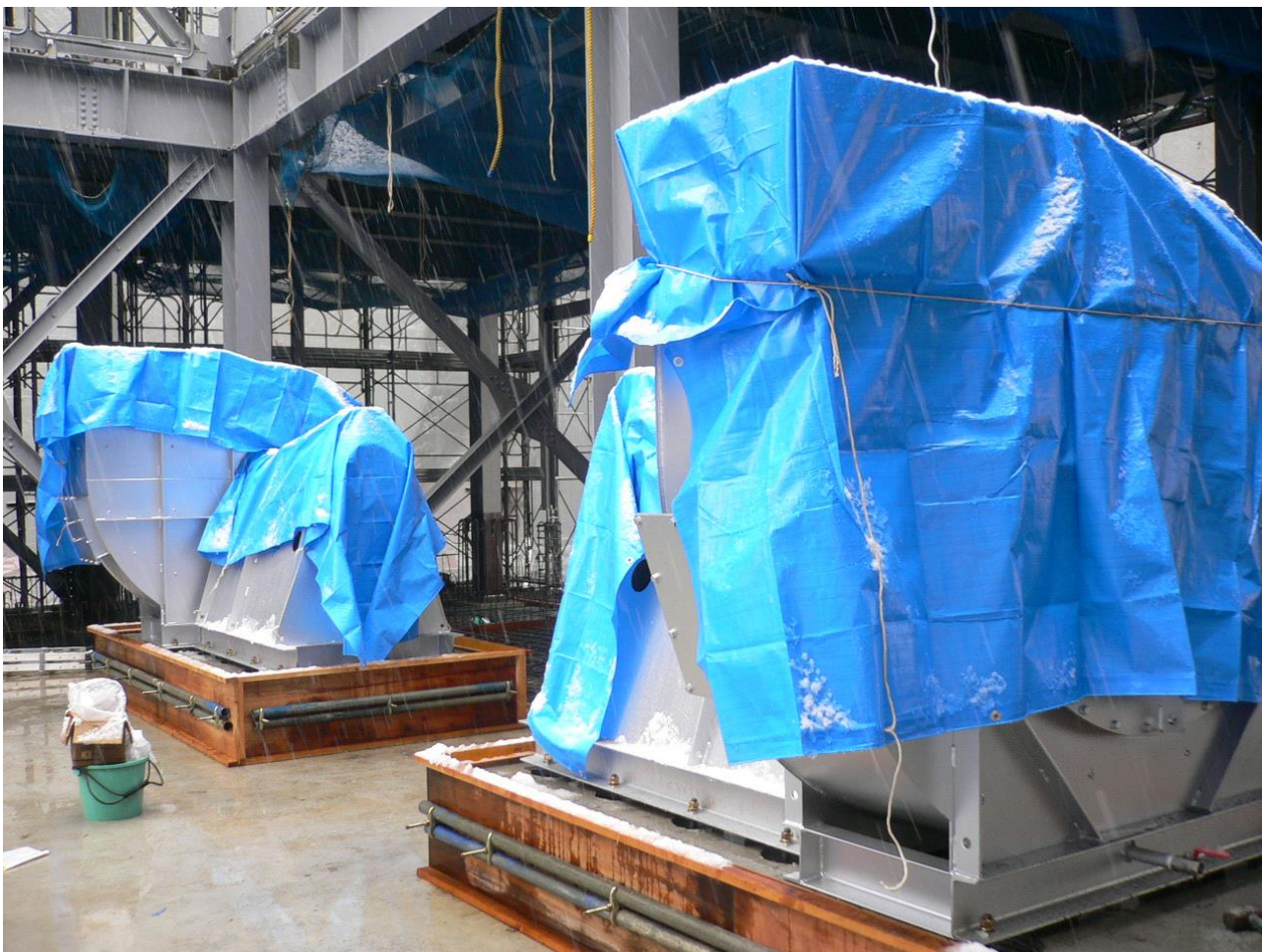
機器（誘引送風機）の据え付けを開始しました（平成 29 年 3 月 21 日）
