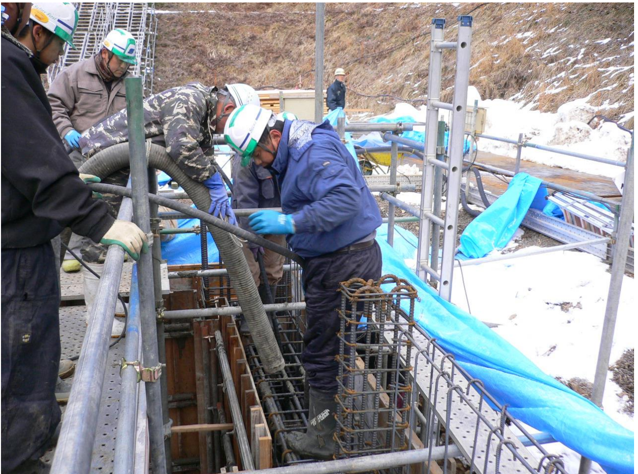
A工区基礎及び地中梁のコンクリート打設（平成 29 年 1 月 19 日）
