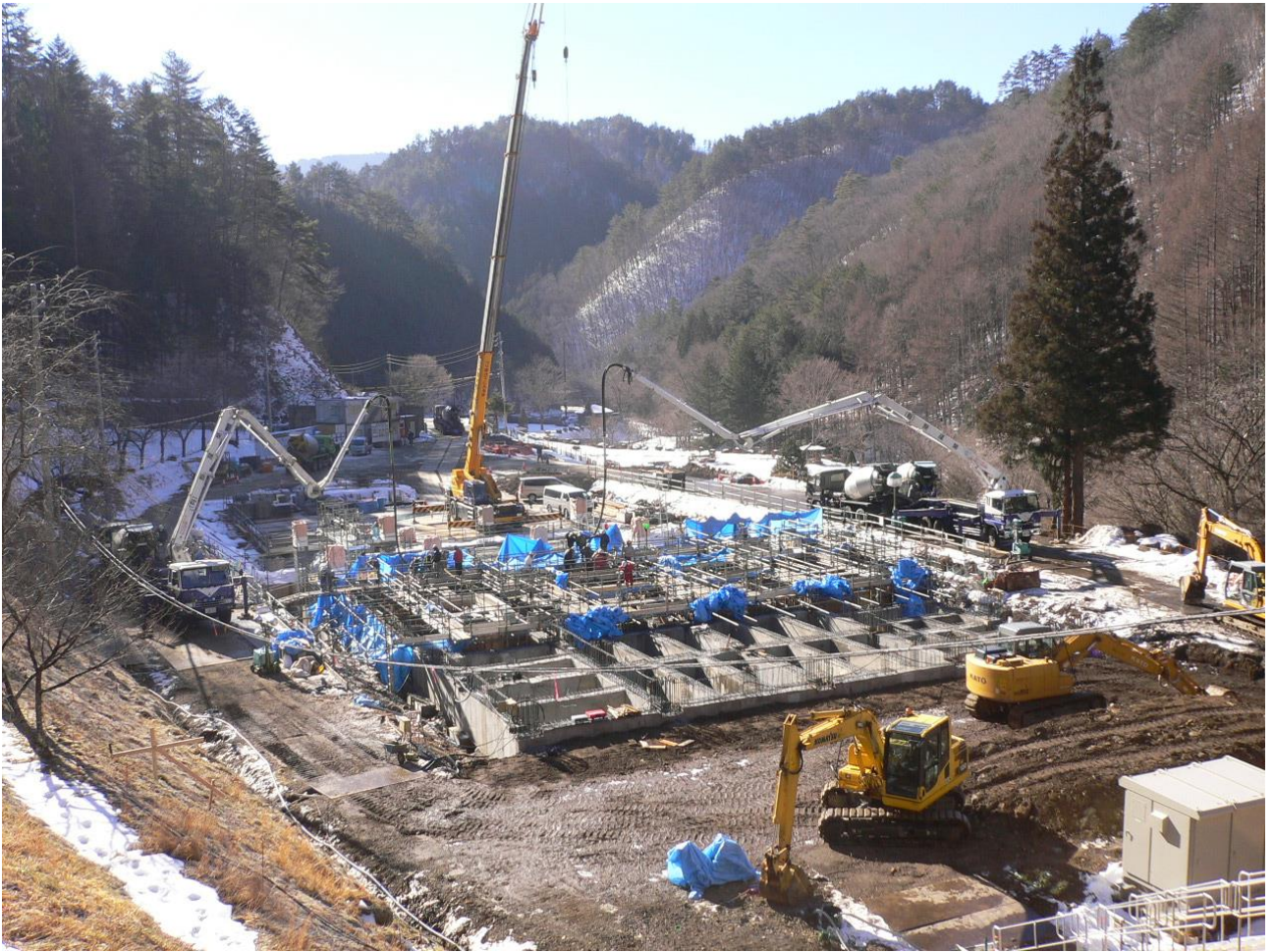
新ごみ処理施設の全景（平成 29 年 1 月 28 日現在）
