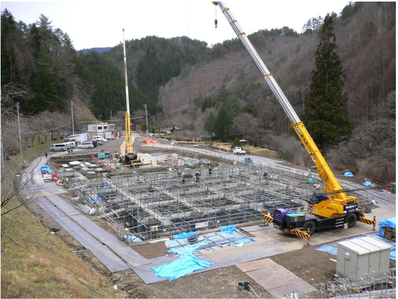
新ごみ処理施設の全景（平成 28 年 12 月 26 日現在）
