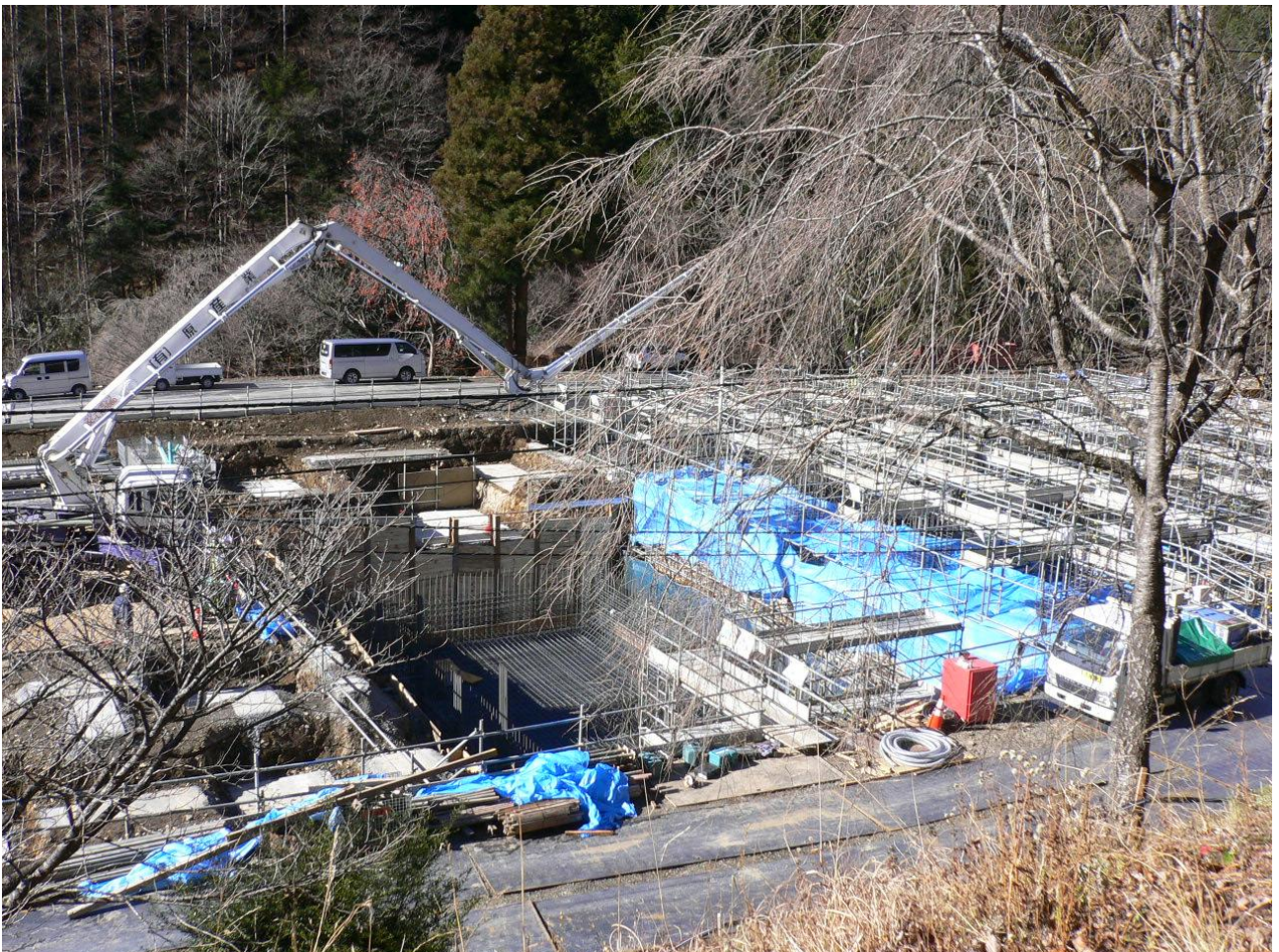
コンクリートの打設を開始しました（平成 28 年 12 月 15 日）
