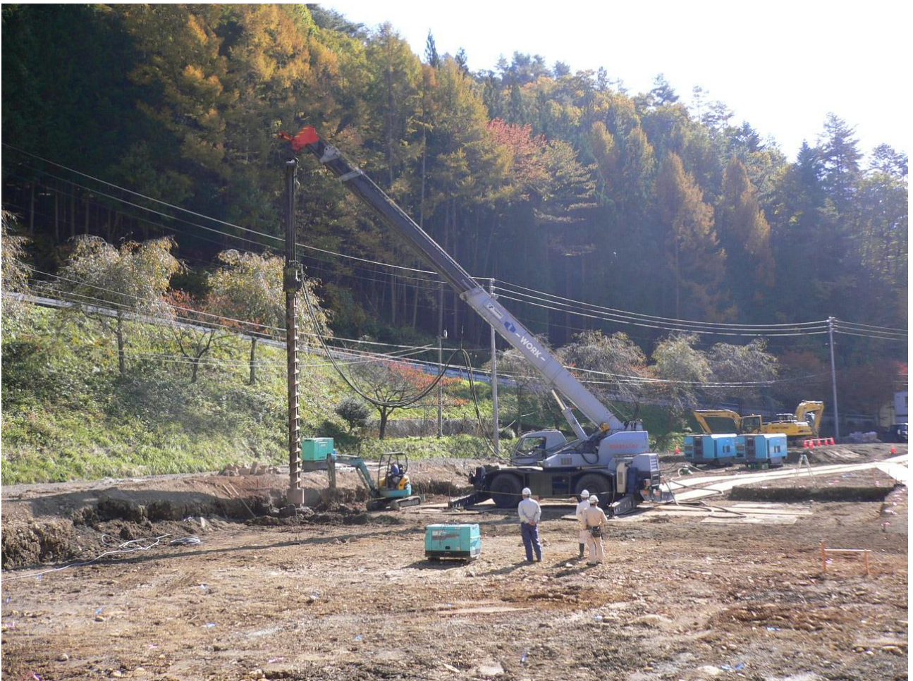
ごみピット部の親杭打設を開始しました（平成 28 年 11 月 7 日）
