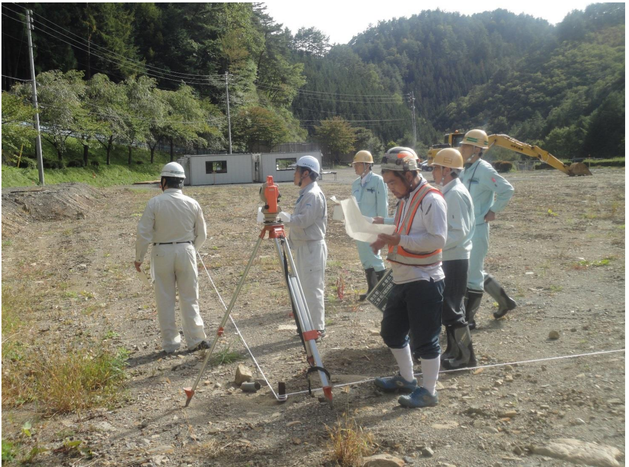
縄張り確認を行い掘削を開始しました（平成 28 年 10 月 14 日）
