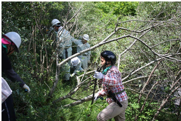
作業中の様子 1
